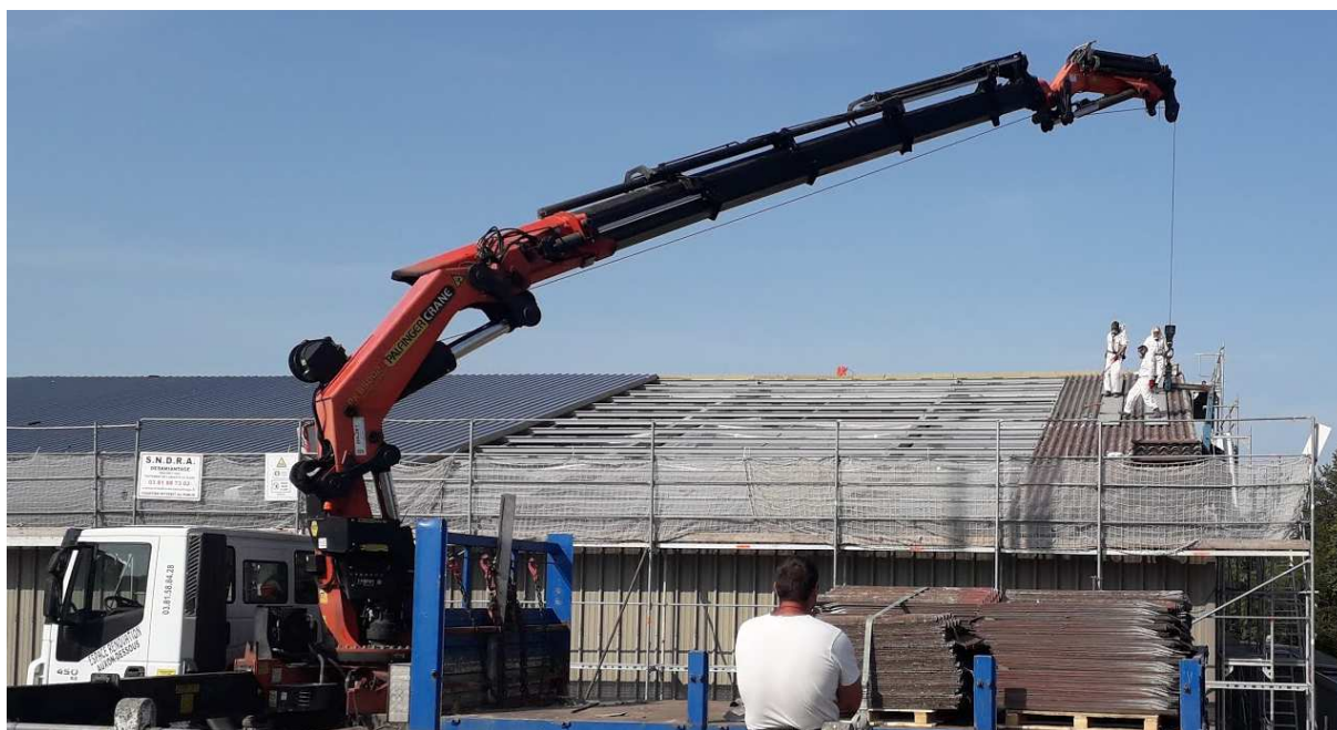
Photo des travaux
